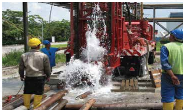
Contoh kerja pengerudian air bawah tanah.
